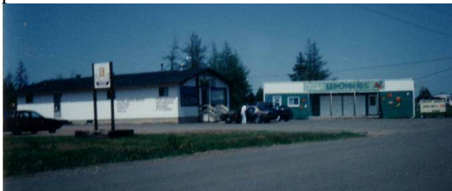
Boulangerie de Grande-Digue
