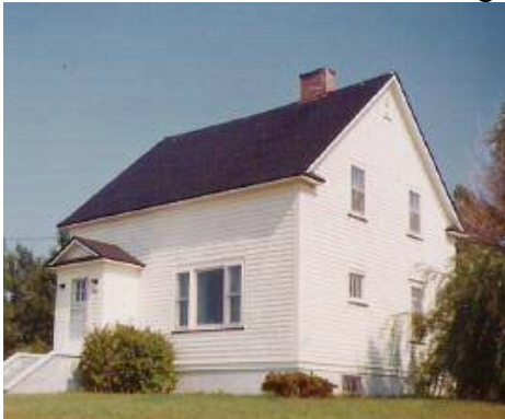
Maison à Point Cross
